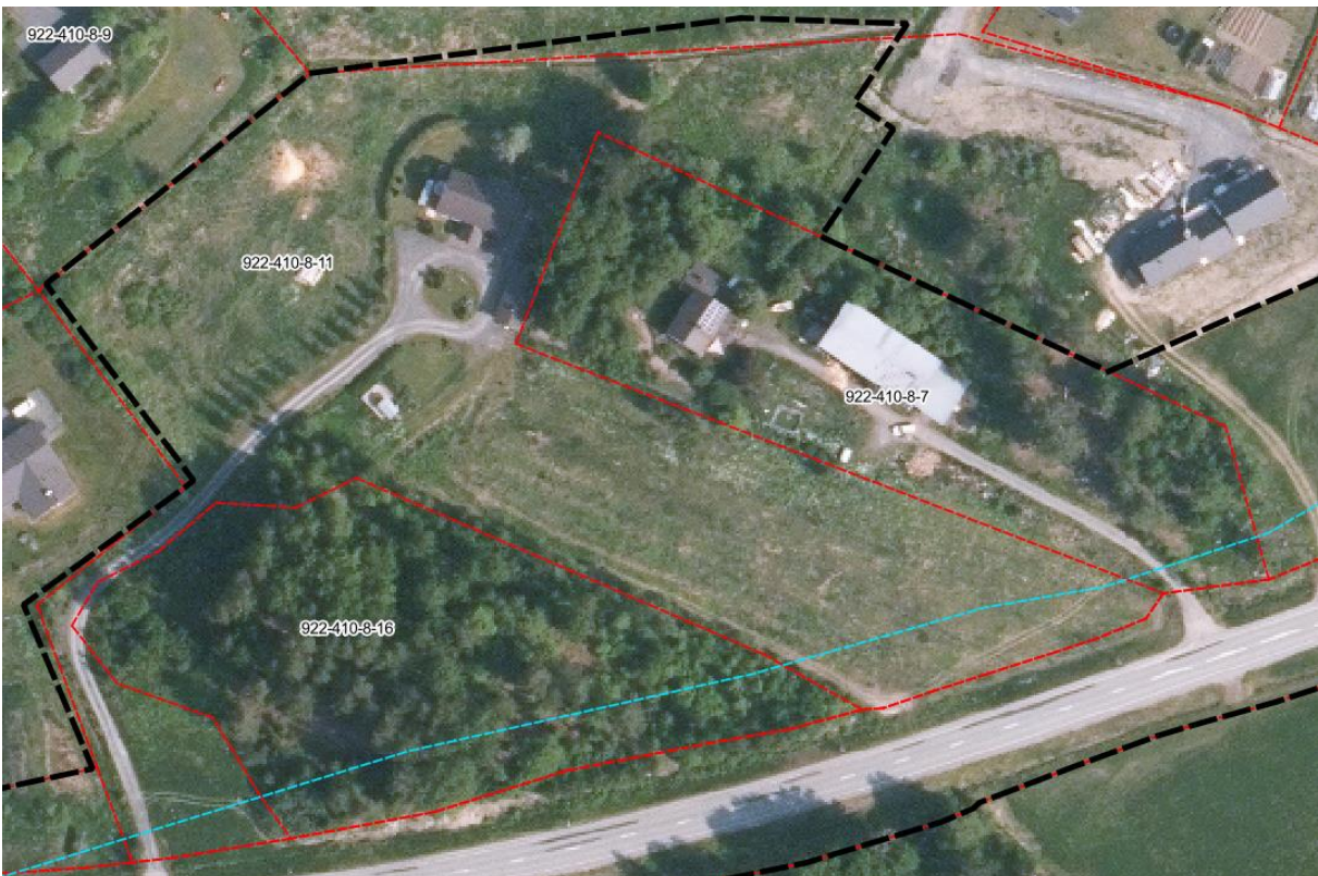
Kuva 10. Suunnittelualueen itäosan rakennukset. Suunnittelualueen likimääräinen raja on merkitty mustalla katkoviivalla. Jalkakäytävän ja pyörätien suunnitelmaluonnoksen mukainen tiealueen raja on merkitty vaaleansinisellä katkoviivalla.
