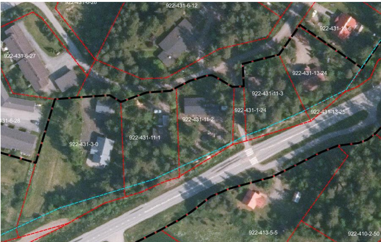
Kuva 9. Osa suunnittelualueen rakennuksista. Suunnittelualueen likimääräinen raja on merkitty mustalla katkoviivalla. Jalkakäytävän ja pyörätien suunnitelmaluonnoksen mukainen tiealueen raja on merkitty vaaleansinisellä katkoviivalla.
